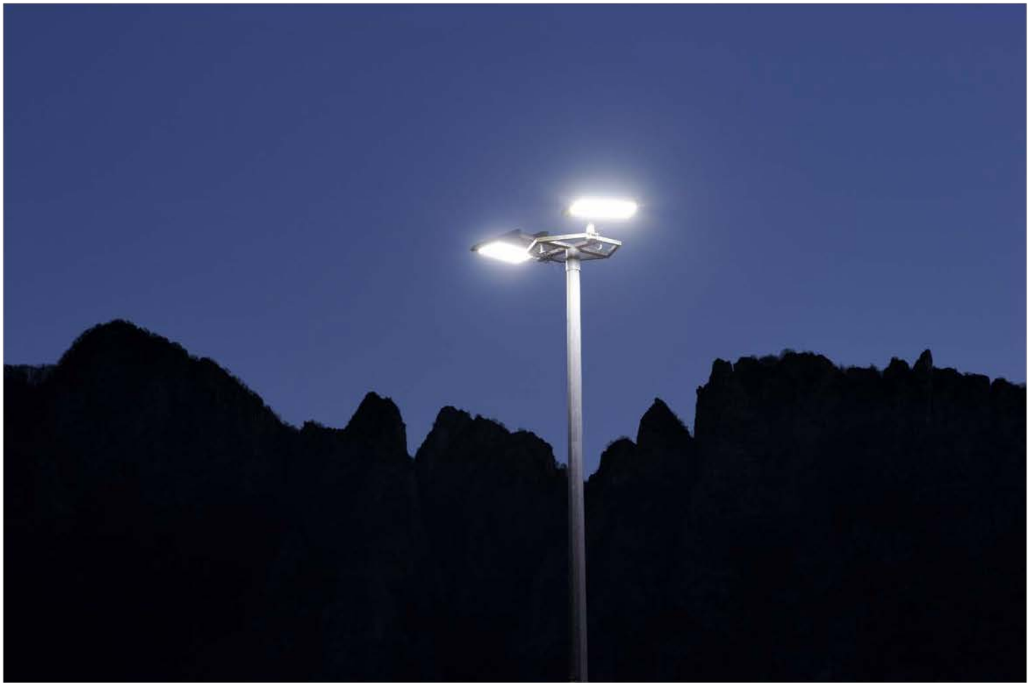
Nel piazzale e nel parcheggio dell'impianto sono state installate 2 Cree Edge™ HO 240 L e 5 XSP1 (courtesy: CREE Europe)
