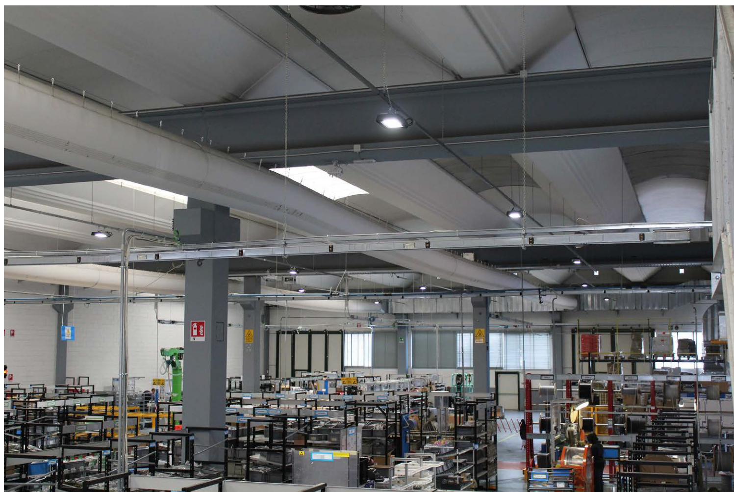
Il relamping realizzato presso l'azienda in provincia di Varese realizzato con lampade della serie NIKA nella versione da 185W con Driver Dimmerabile (courtesy: ROLD Lighting)
