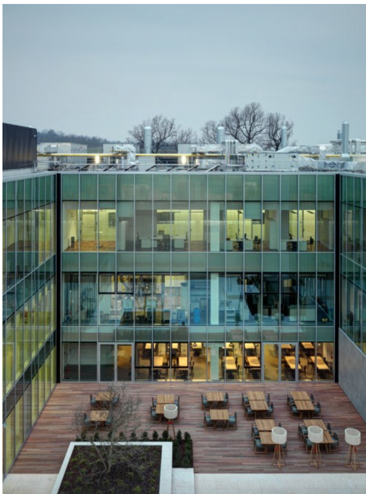
Per gli uffici, sono stati utilizzati apparecchi 'Tecton C LED' ad alta efficienza energetica e plafoniere LED 'Mirel' da incasso (courtesy: Zumtobel)
