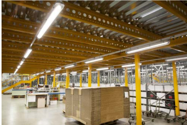
Valdengo. Gruppo Bonprix Italia. Un'immagine della nuova illuminazione della struttura (courtesy photo: 3F Filippi)
